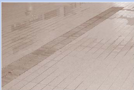
ภาพที่ 199 : ทางระบาย
