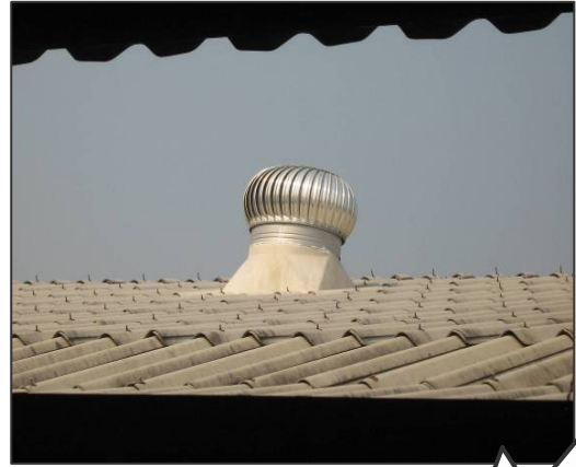
ภาพที่ ๑๐ ตัวอย่างเพดานสะอาด หลอดไฟมีฝาครอบ หลังคาติดตั้งลูกหมุนเพื่อระบายอากาศ
