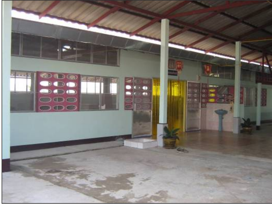
ภาพที่ ข9 ตัวอย่างการกันผนังอาคารผลิตแบบที่ 2 ก่ออิฐสูงประมาณ 80 เซนติเมตร จากนั้นจึงกันผนังด้วยมุ้งลวดสลักกับก่ออิฐ ประตูทางเข้า-ออกมีม่านพลาสติกกัน
